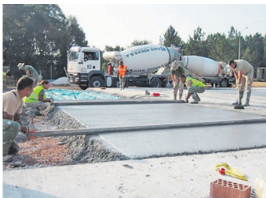
Cuatro meses de obras. Un centenar de militares de la Brilat han urbanizado en Cabo Noval más de 4.500 metros cuadrados para los vehículos antiminas de la misión de Afganistán. BRILAT
